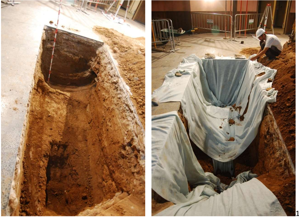
Fig. 9-10. Vista final de la cala i cobriment amb geotèxtil.
